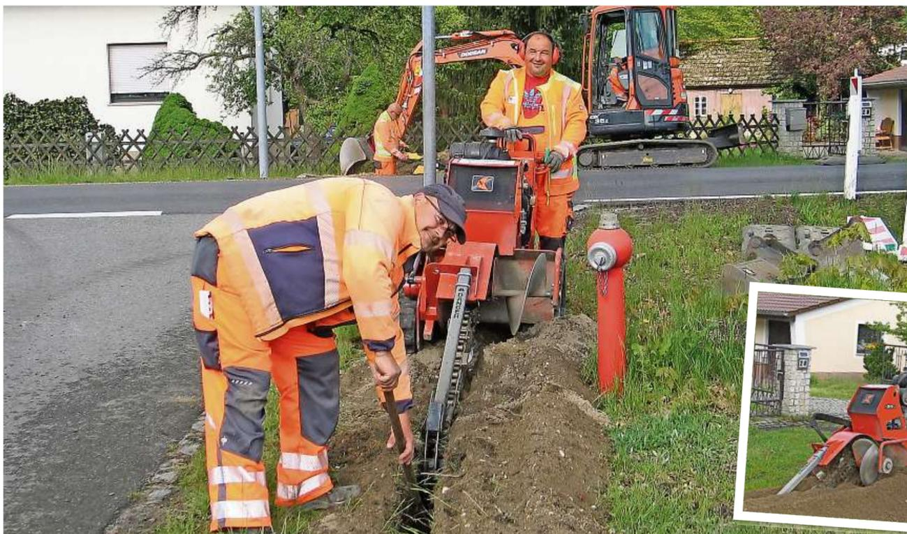
Mit der Fräse hat Dirk Winterlich auf dem Amselweg in Reichwalde 200 Meter Kabelgraben ausgehoben. Norbert Scheer (li.) musste mit der Schaufel nur noch Kleinigkeiten nacharbeiten. Danach werden das Glasfaserkabel eingeleitet und etwa 20 Hausanschlüsse verlegt.
